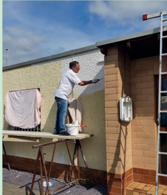
Die beiden Helfer bei der Arbeit.
