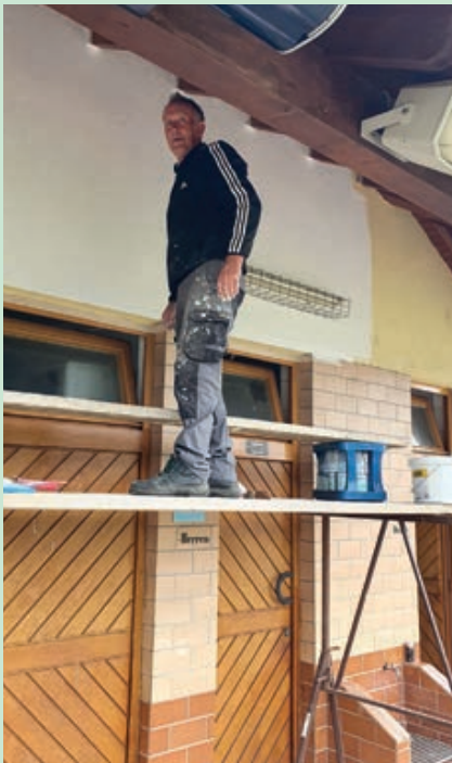
Die beiden Helfer bei der Arbeit.
